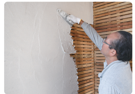
『瀬戸漆喰』木小舞への施工
